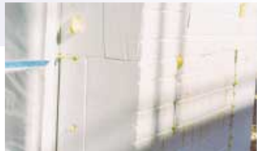
Große Dämmstoffpakete sind wirtschaftlich und sparen den Löwenanteil Energie in einem Altbau.
