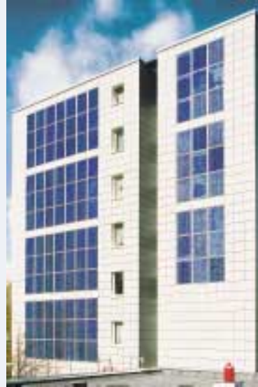
Südfassade nach der Modernisierung
